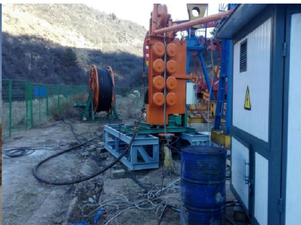
液压无杆泵排采
